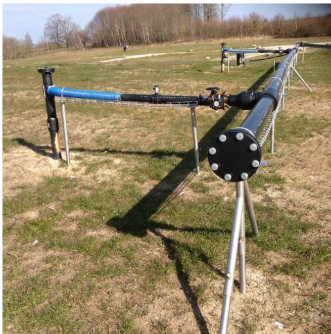
Vue alvéole 8.1 réhabilitée (réseau biogaz)
